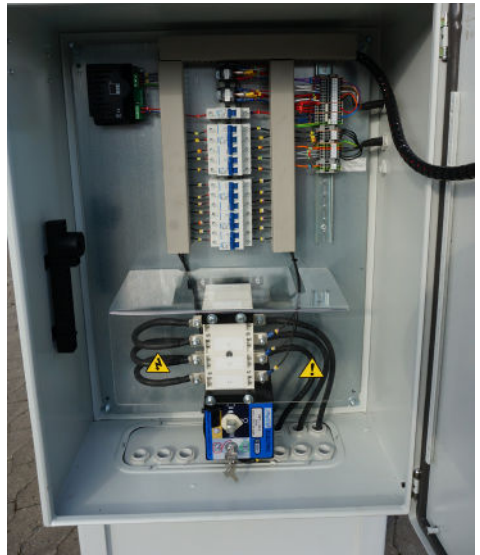
Lovol 50 kVA (72 A) med automatisk opstart og indbygget omskifter (ATS).
